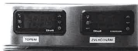
Ovládání vozíků se zvlhčováním
